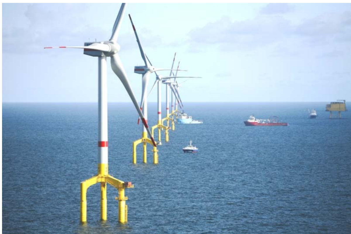
Vindmøller med flere MW og offshore-fundamenter medfinansieret af genopretningsprogrammet installeret ved Bard I i den tyske del af Nordsøen
