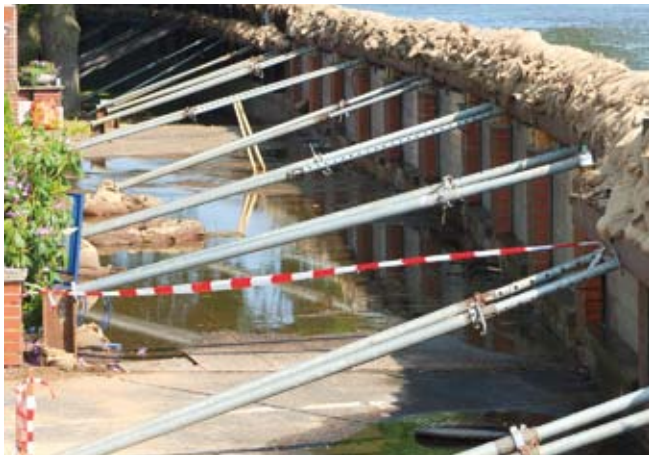
Schutzdamm in Wusseegel
