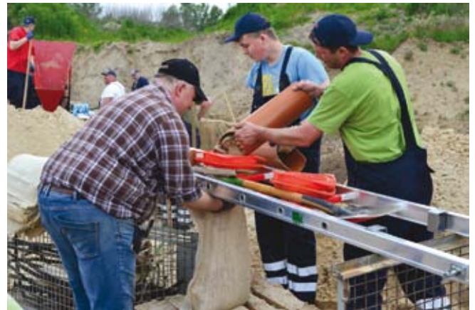
Unterschiedlichste Techniken wurden ausprobiert, wie sich Sandsäcke am einfachsten befüllen lassen
