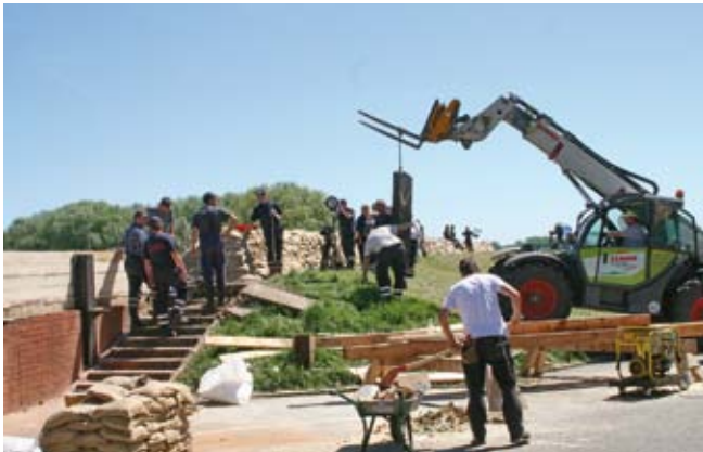
Deichbauarbeiten in Wussege
