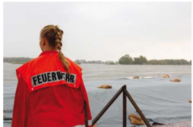
mit Planen abgedeckter Deich in Neu Darchau
