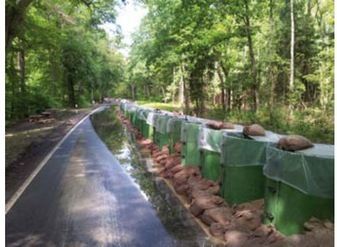
mobiler Schutzwall in Gartow
