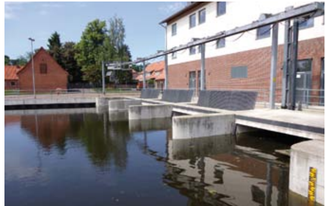
Schöpfwerk in Hitzacker
