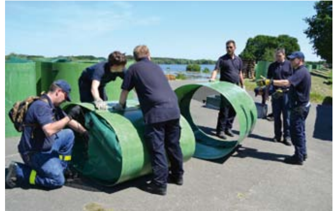
Aufbau des mobilen Schutzdamms in Gartow
