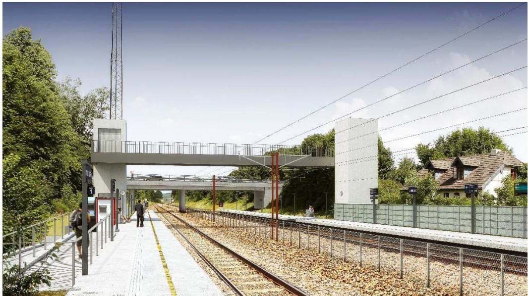
Tilvalg 1 med elevatorer og normal perronbredde.
