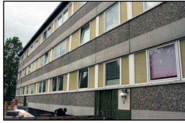
Traneparken før renoveringen.
