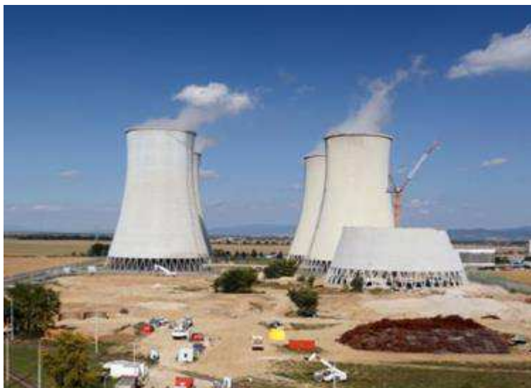
Figur 3 – Nedrivning af køletårne
