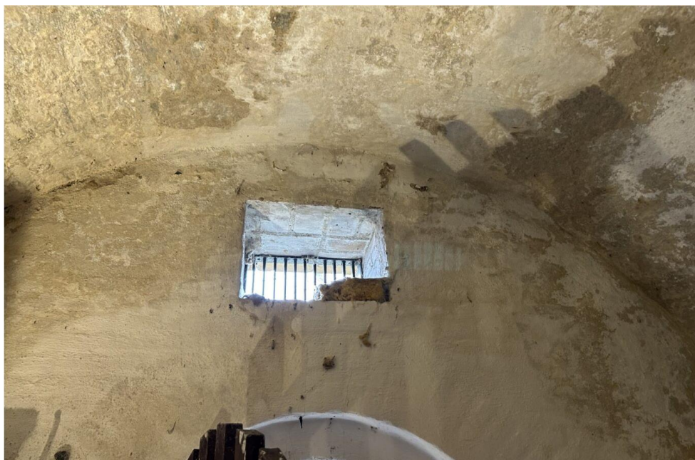
Figur 10-29 Eget loftshvælvning og åbning der tillader adgang for flagermus i krudtmagasinet på Bastionen.
